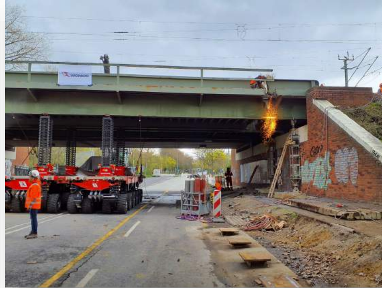
Teilrückbau der Brücke
