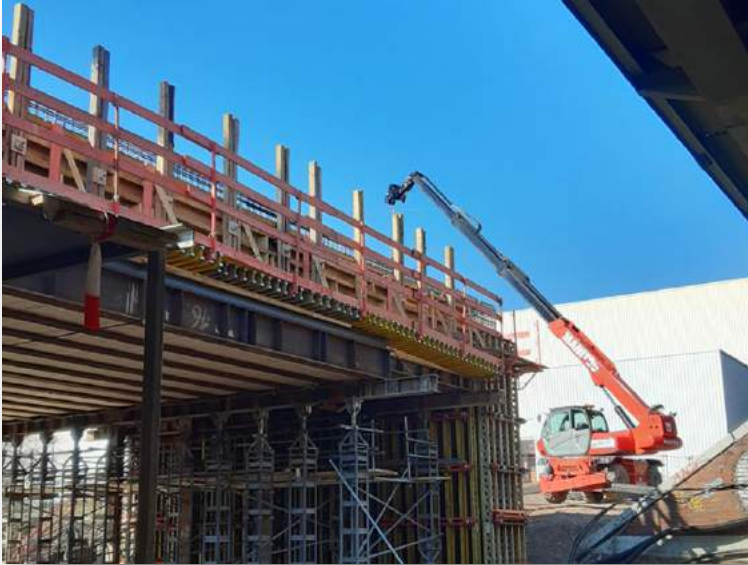
Bauseitige Herstellung der Erweiterung
