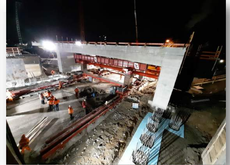
Einschub der Brücke
