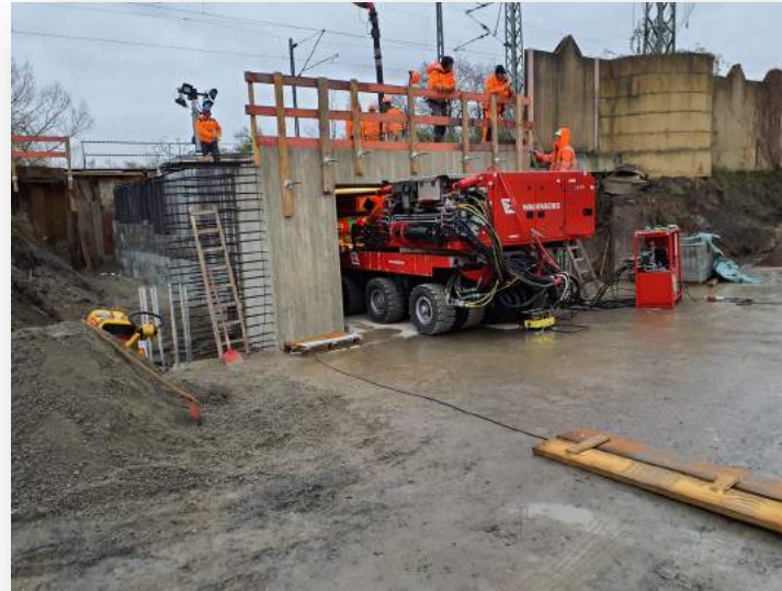
Einschub des neuen Brückenbauwerks
