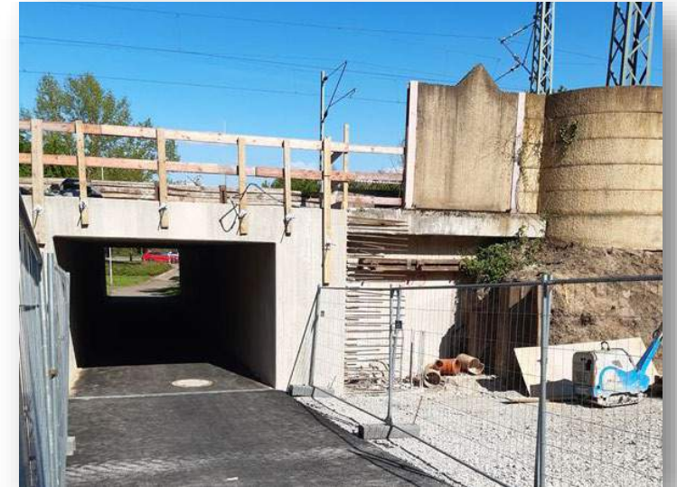
Erweiterte Brücke Carl-Rumpff-Straße
