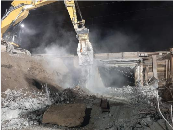
Teilabbruch des Bestandsbauwerks
